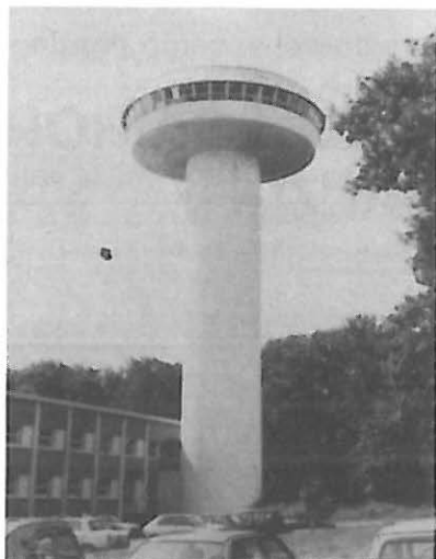
La torre solare in cemento armato
