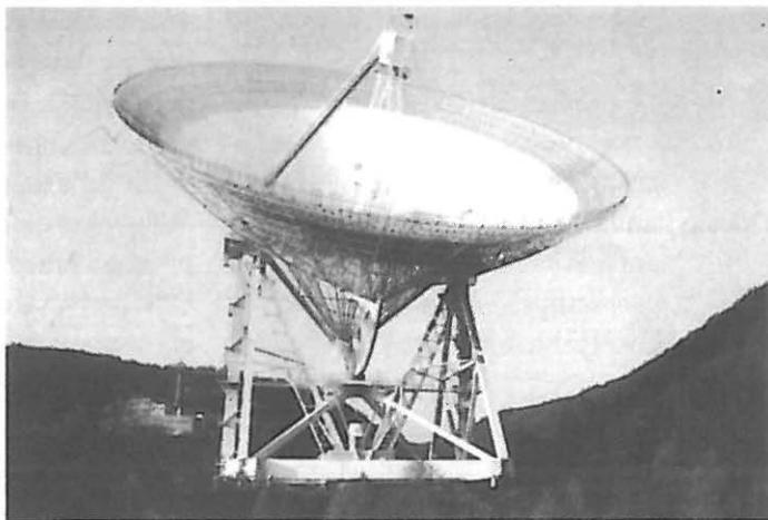
*La più grande antenna parabolica orientabile del mondo (D=100 m) : quella del radiotelescopio di Effelsberg (D)*
