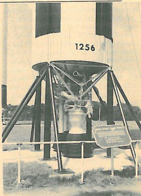
Parte terminale con i due motori del primo stadio del missile Titan II, utilizzato per le missioni Gemini.
