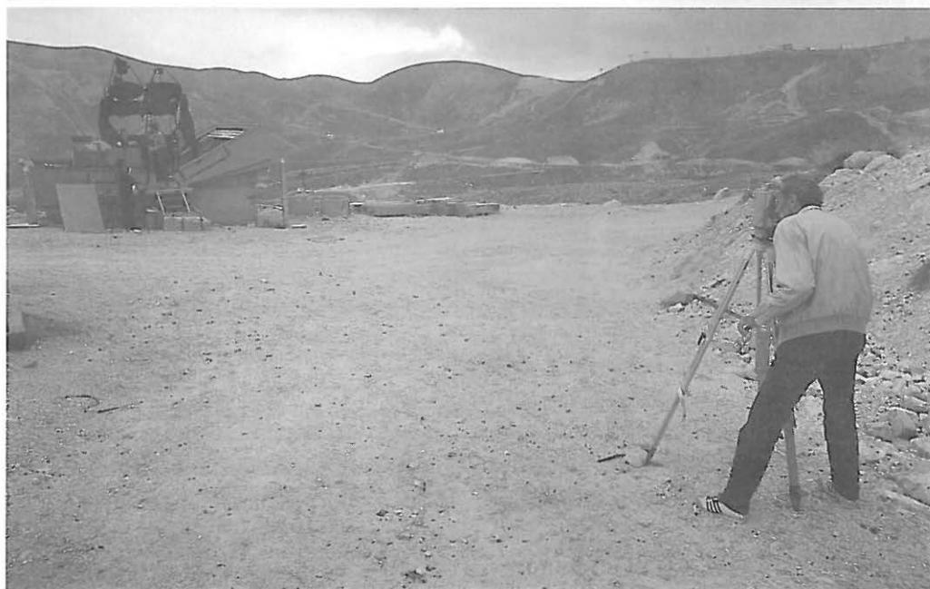
*Orientamento della montatura con il teodolite*
